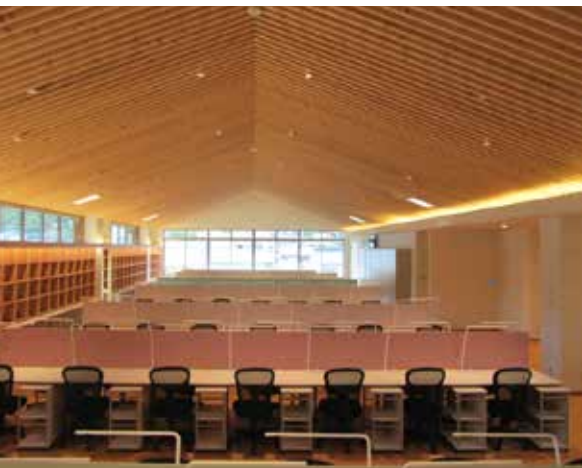
本社ビルには建築材として使用されない小田原ひのきを利用し、地元の森林活性化を促進。
