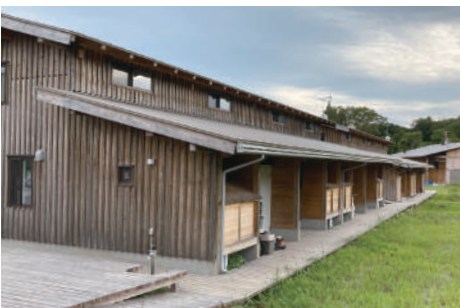
板倉工法にて建てられたアパート棟
